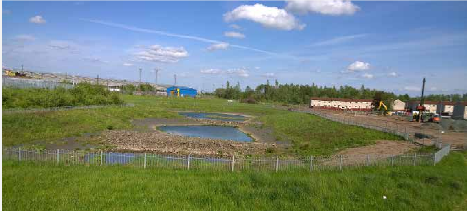
Toryglen SuDS Pond
